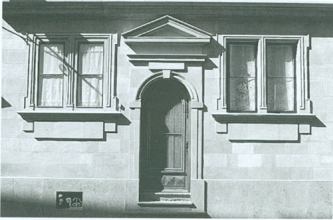
16. Petite porte de la façade sur rue (entrée des bureaux)
