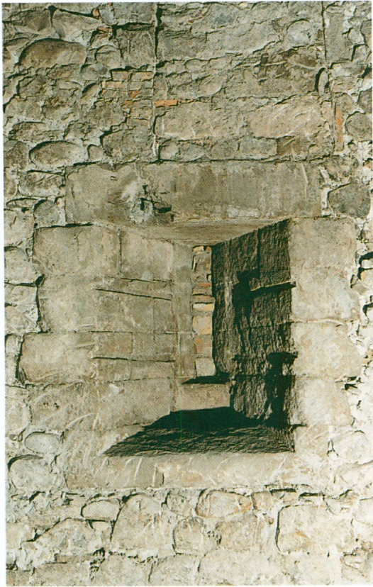
15. Rue de Coutance n° 8 bis « ouest » | Archère découverte au rez-de-chaussée dans le mur donnant sur les vignes et près épiscopaux. La façade arrière des maisons médiévales constituait alors un véritable front de fortifications.
