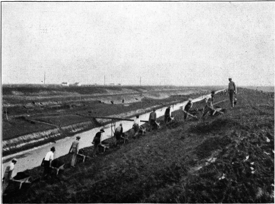
Abb. 4. Bonifica Parmigiana-Moglia. Ausheben eines Kanales im Handbetrieb.
