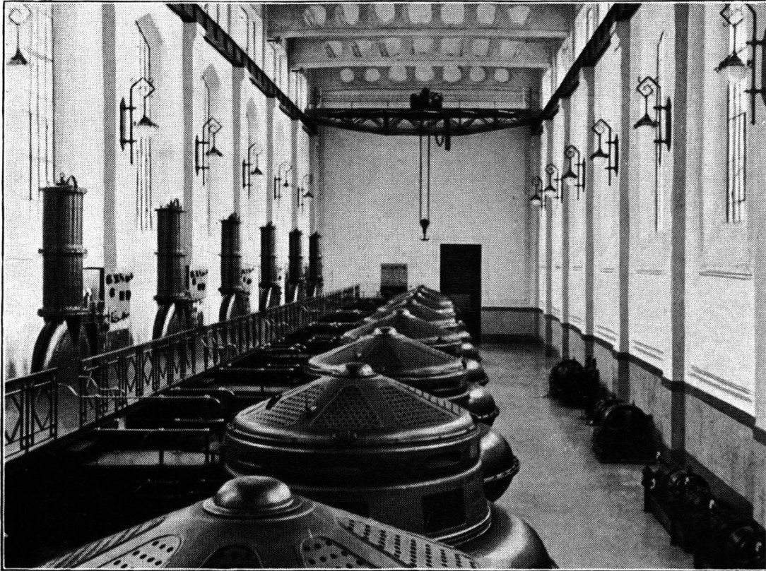
Abb. 1. Bonifica Parmigiana-Moglia. Pumpenanlage San Siro.
