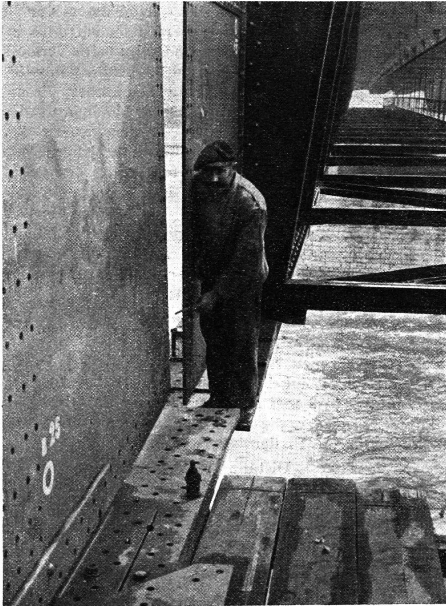
Abb. 4. Trennungsfuge zwischen den beiden Trägerhälften.
