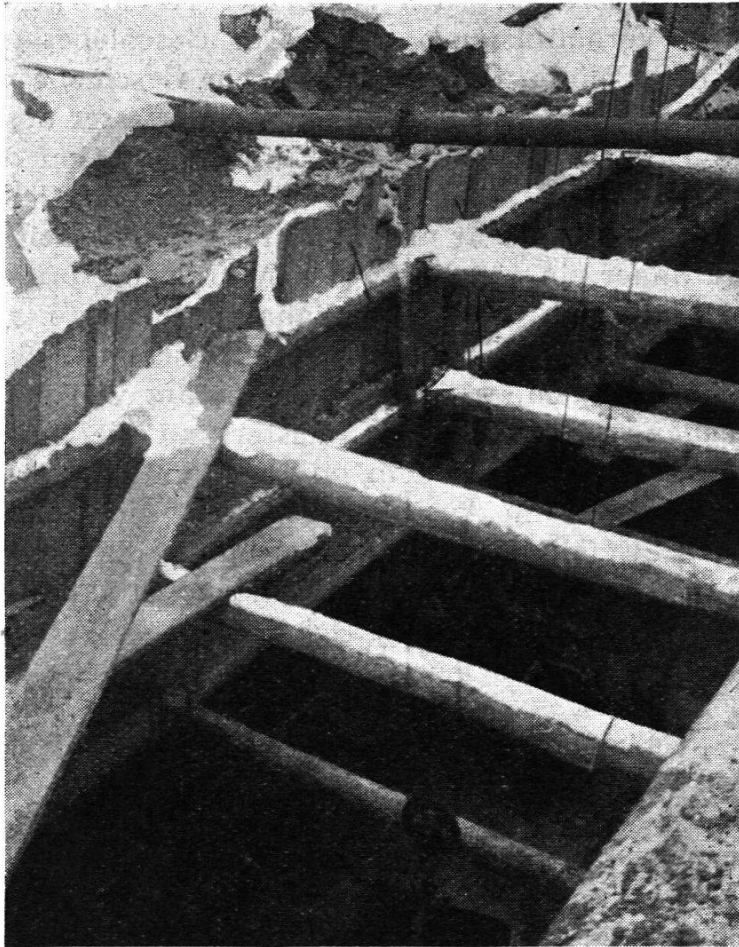
Abb. 4. Aushub der Fundamente.
