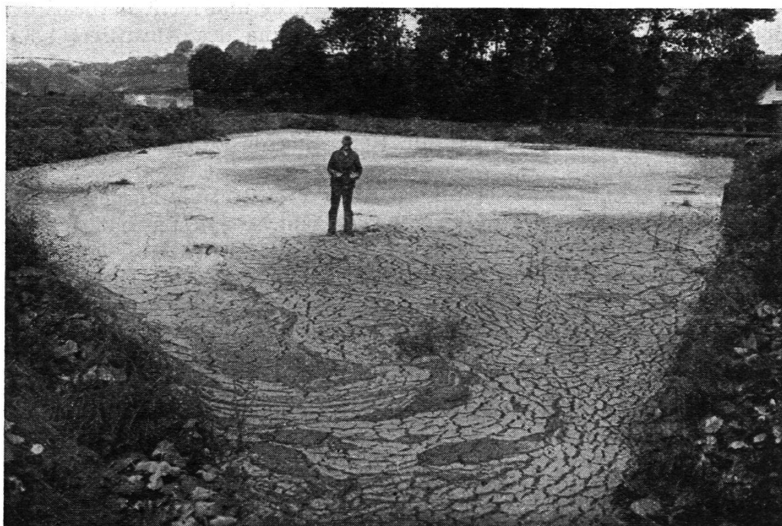
Abb. 7. Blick auf ein abgebrochenes Erdbecken.
