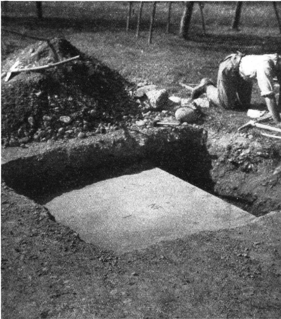
Fig. 16. Basisanfang Aarberg: 1927 bloßgelegte Deckplatte.
