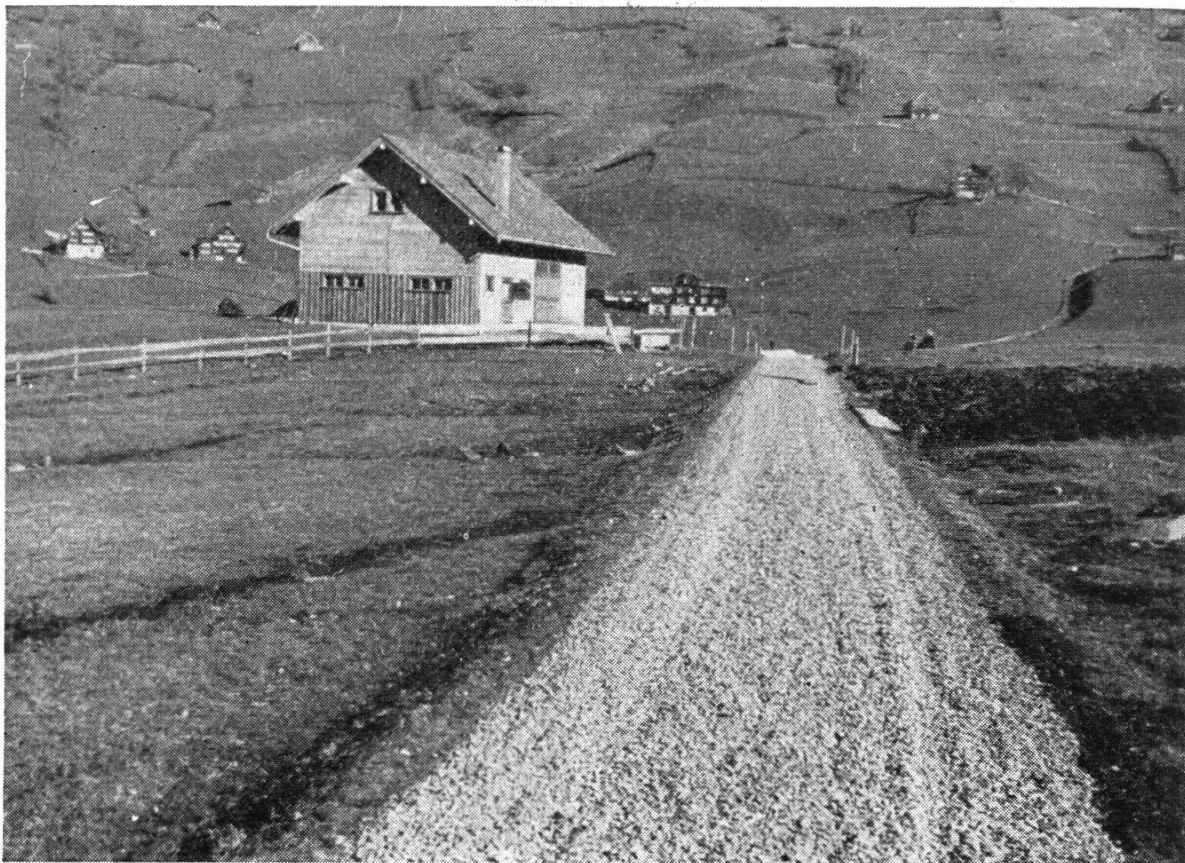
Güterstraße nach Hinterbüel mit neu erstellter Scheune
