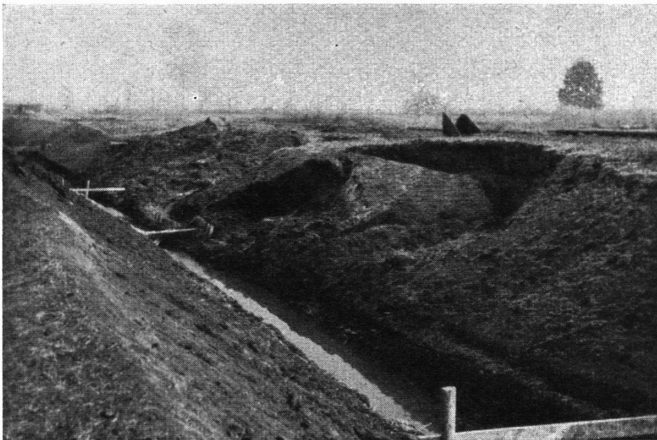
Böschungseinsturz
