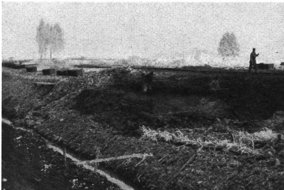
Ausfüllen eingestürzter Böschungen mit Stauden und Torf
