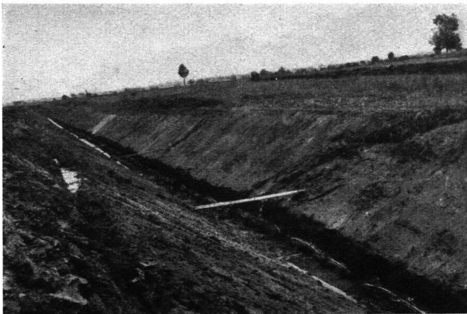
Faschineneinbau zur Sicherung der Böschungsfüße
