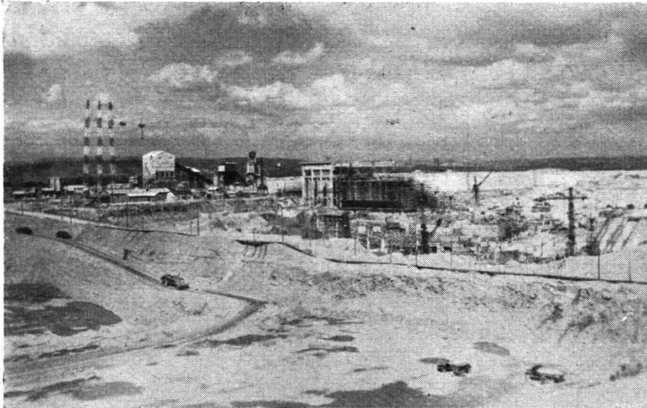
Donzère-Mondragon: Un chantier hérissé de blondins et de grues
