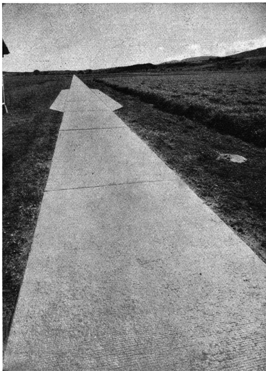
Fig. 7. Plaine de l'Orbe. Chemin de 4 m. de largeur, bétonné sur 2.80 m., avec place de croisement. (Vue prise au milieu de la longueur.)
