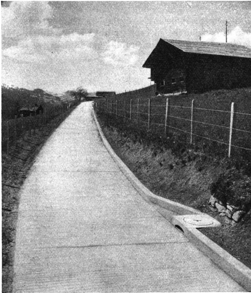
Fig. 6. Rougemont, route alpestre, largeur 3.50 m., bétonnée sur 2.80 m., pente 7 %, altitude 1100 m.
