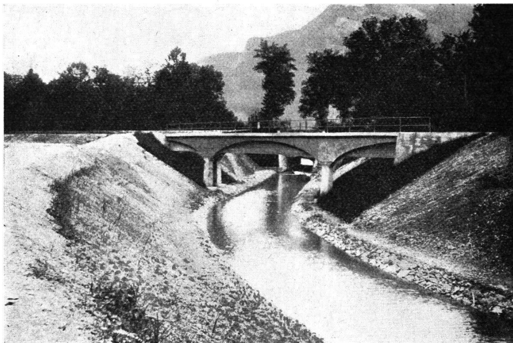
Fig. 5. Acqueducs de la Grande-Eau et du bief industriel de la Monneresse sur le Grand-Canal. Différence d'altitude des plans d'eau: 4.80 m.
