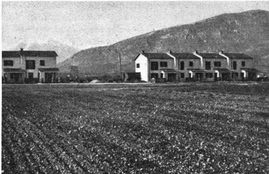
Bild 7. Arbeitersiedlungen östlich Avezzano, je vier Zimmer und Küche, Schweinestall und Geräteraum.
