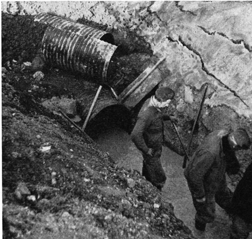
Pose d'une canalisation de 80 cm de diamètre
