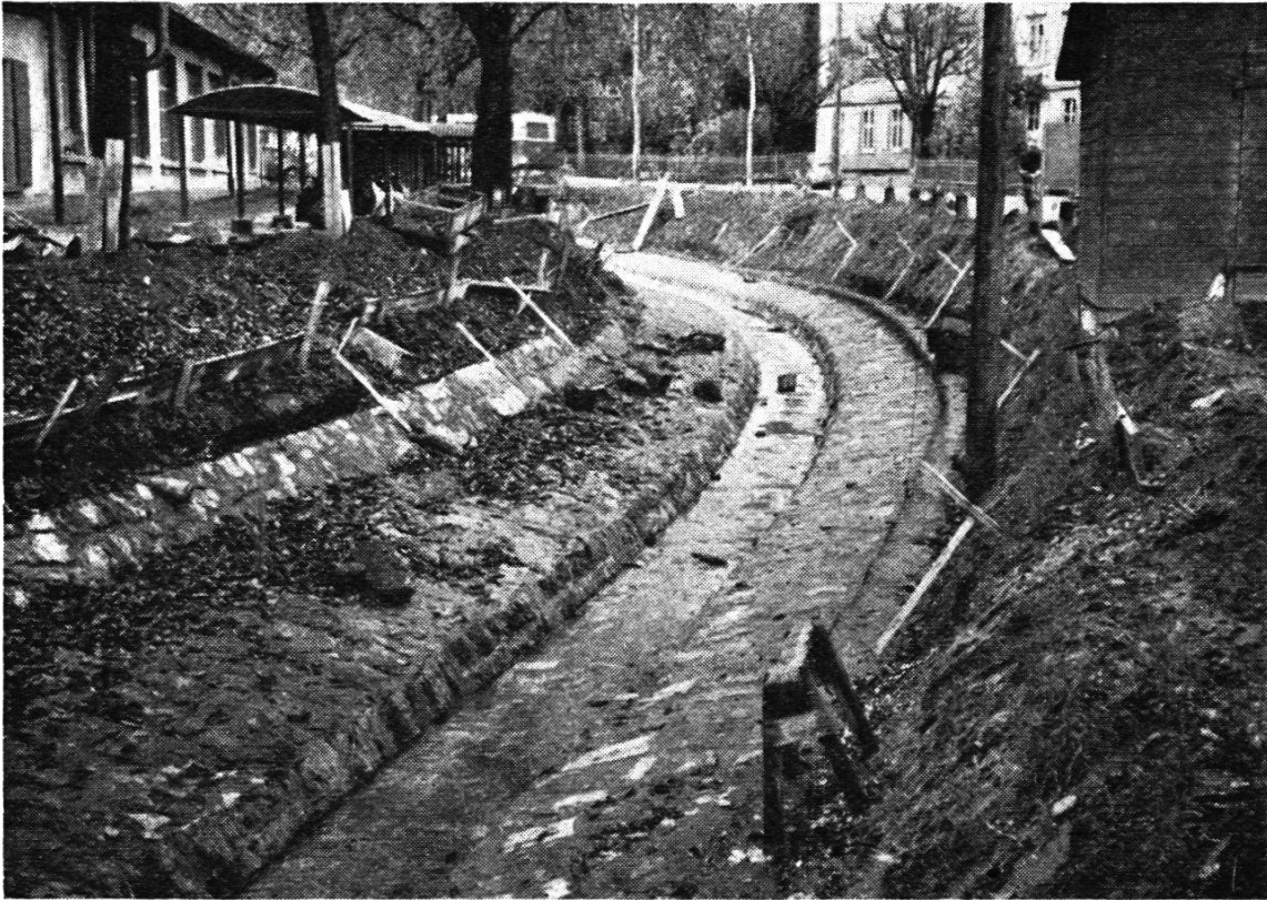
Der korrigierte Stadtbach im Oberlauf mit gepflasterter Niederwasserrinne und beidseitigen Bermen. Weitgehend ist noch der alte Uferschutz ersichtlich.
