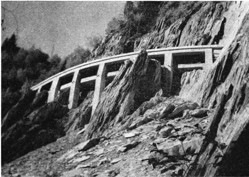
Lukmanierstraße. Galerie gebaut 1956/57
