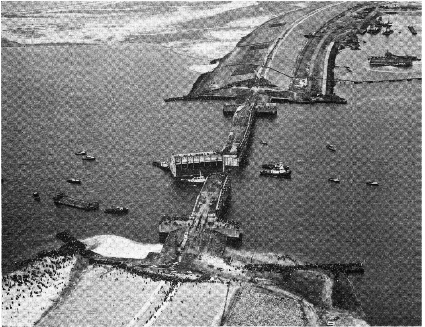
Bild 13. Schließung des ersten Dammes im Rahmen des Deltaplanes am 24. April 1961
