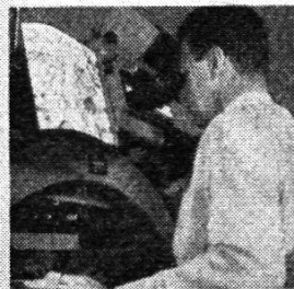
Arbeit am Auswertegerät Autograph Wild A 8 mit elektrischem Koordinatenregistriergerät EK 4
