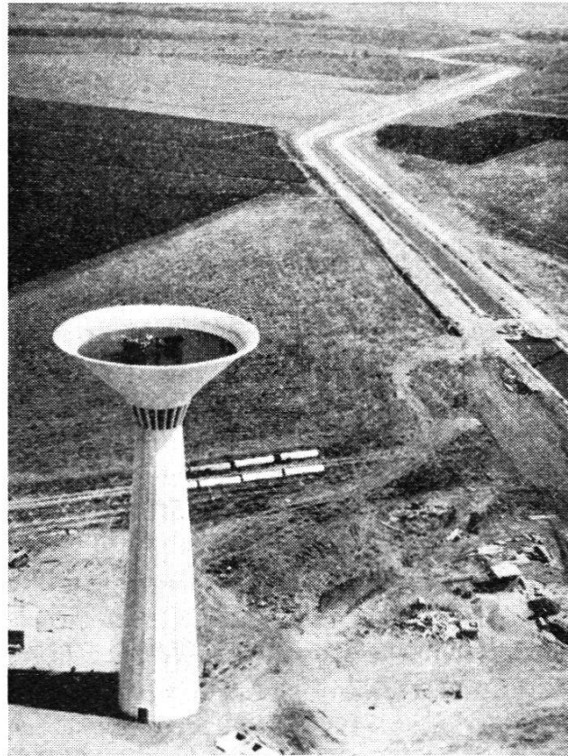
Abb. 3. Der Sekundärkanal bringt das Wasser an das Entnahmepumpwerk (im Bild nicht sichtbar rechts außen). Dieses fördert über den Wasserturm in das Druckrohrnetz zu den Regnern
