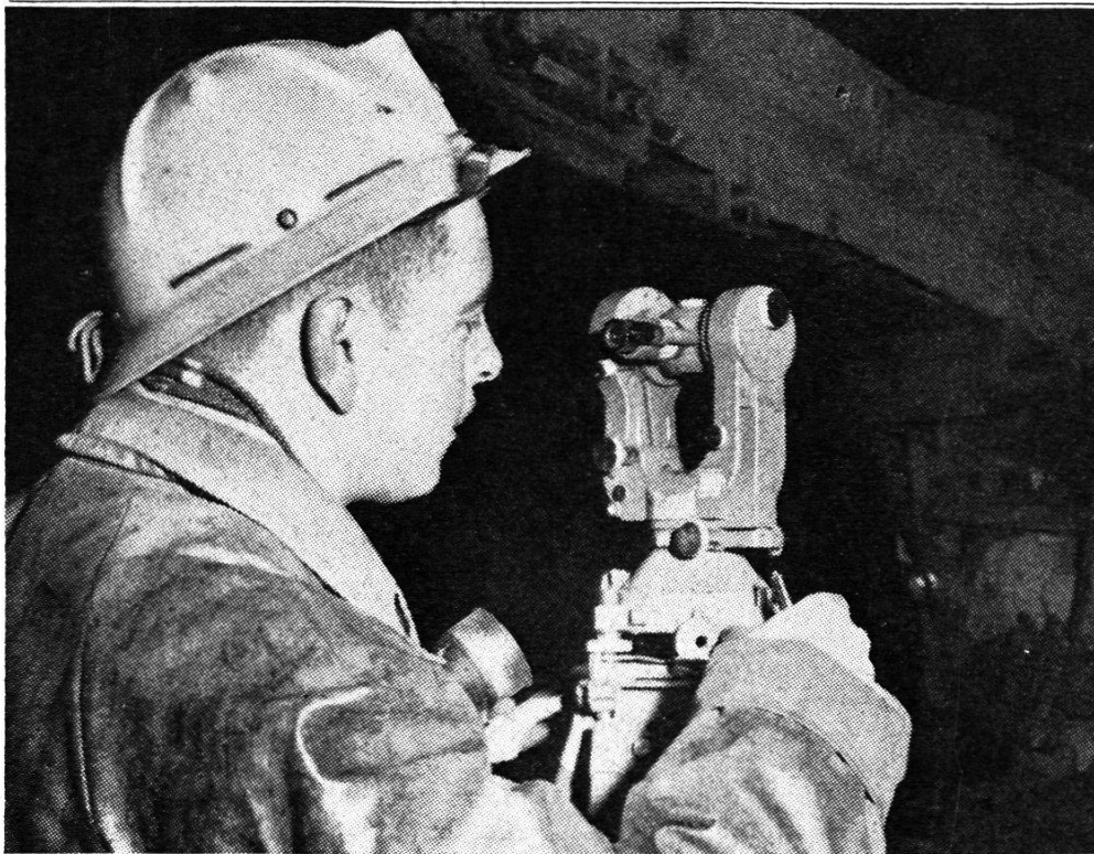
Vermessungsingenieur mit Universal-Theodolit Wild T2 bei Absteckungsarbeiten im 11 km langen Mont-Blanc-Tunnel
