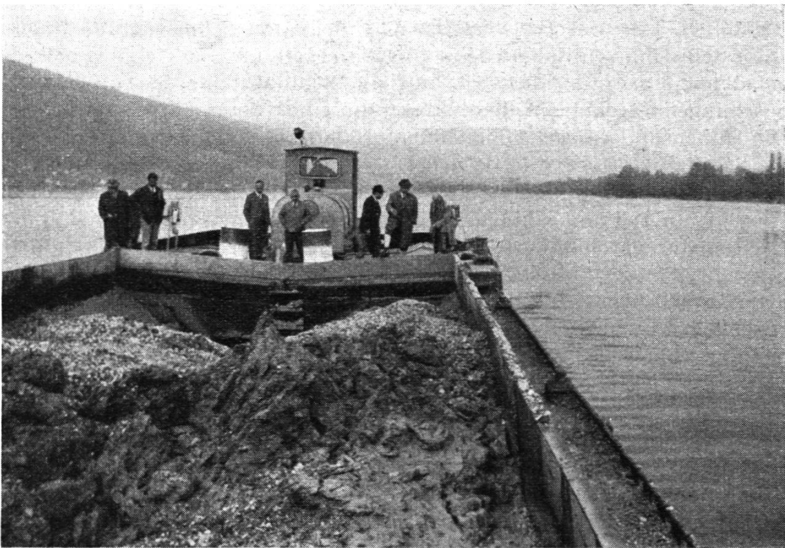
Bild 5. Entleerung der Klappschute auf dem Bielersee (Photo Lehmann, Stud. ETH, Zürich)
