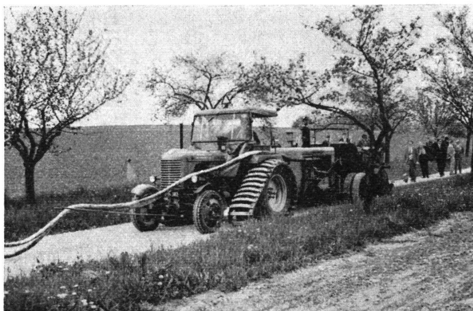
Bild 4. Straßenstabilisierung in Niederösterreich
