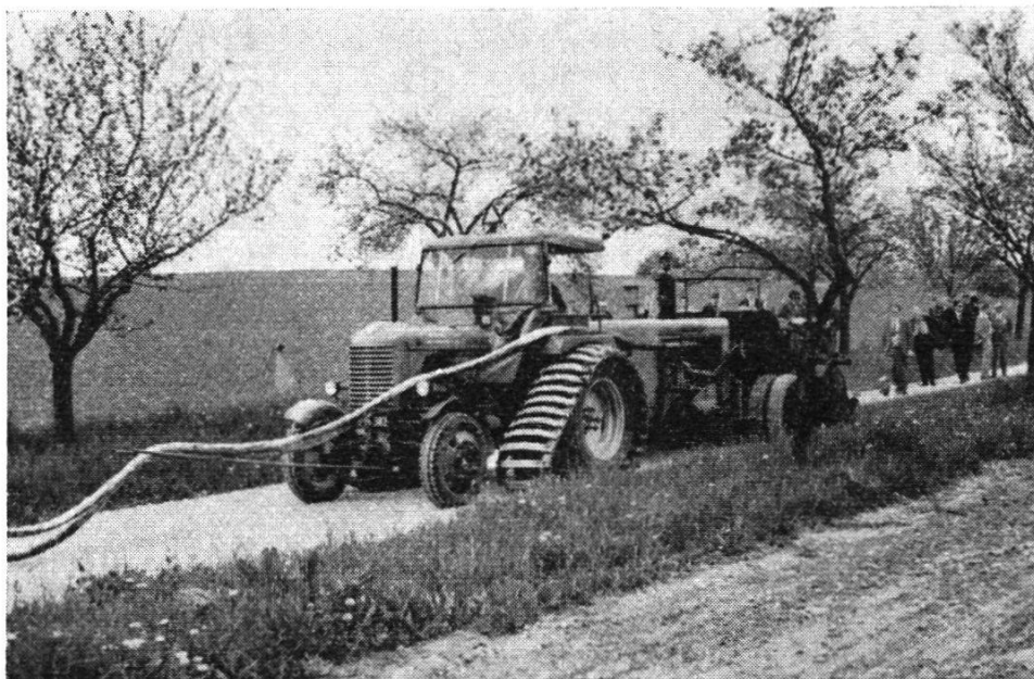
Bild 4. Straßenstabilisierung in Niederösterreich
