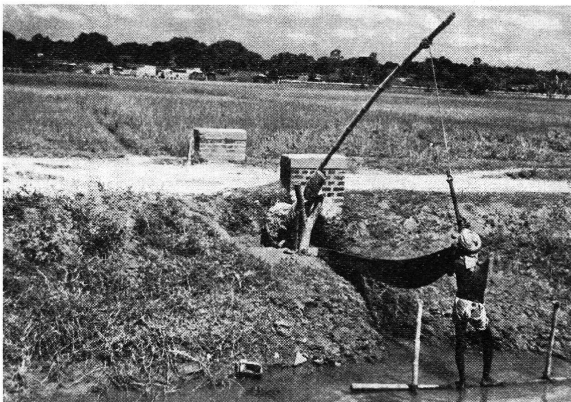
Hebeanlage in Südindien
