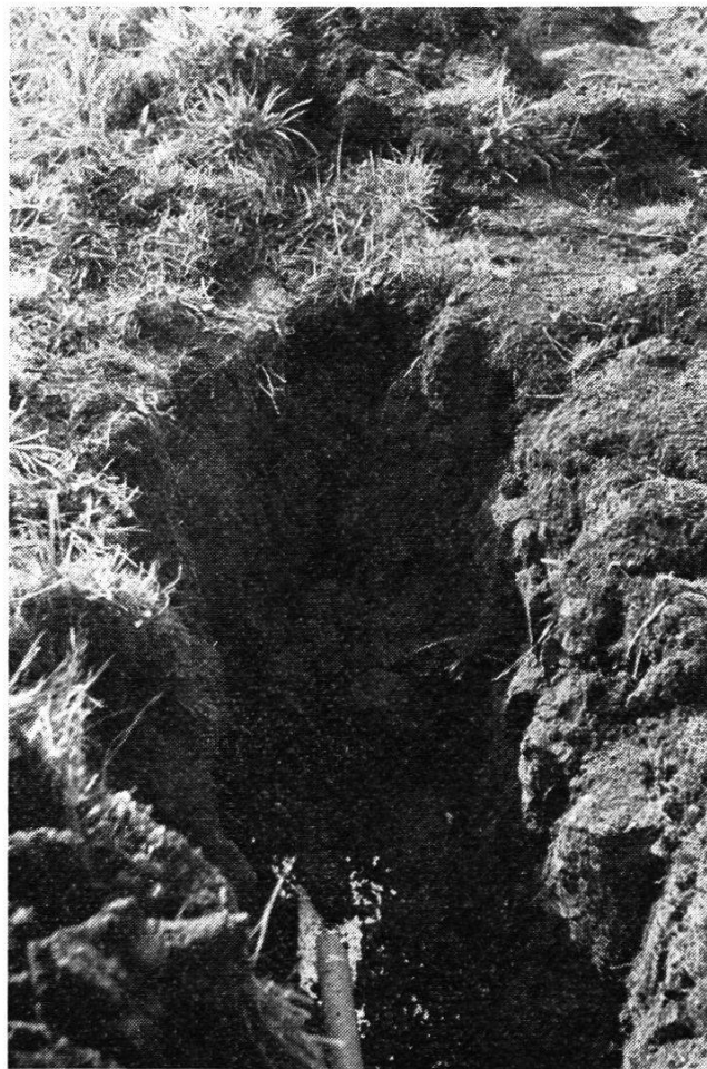
Bild 4: Das mit dem Beauchamp-Dränpflug ohne Grabenaushub eingezogene PVC-Dränrohr ist rundum mit Styromull abgefiltert
