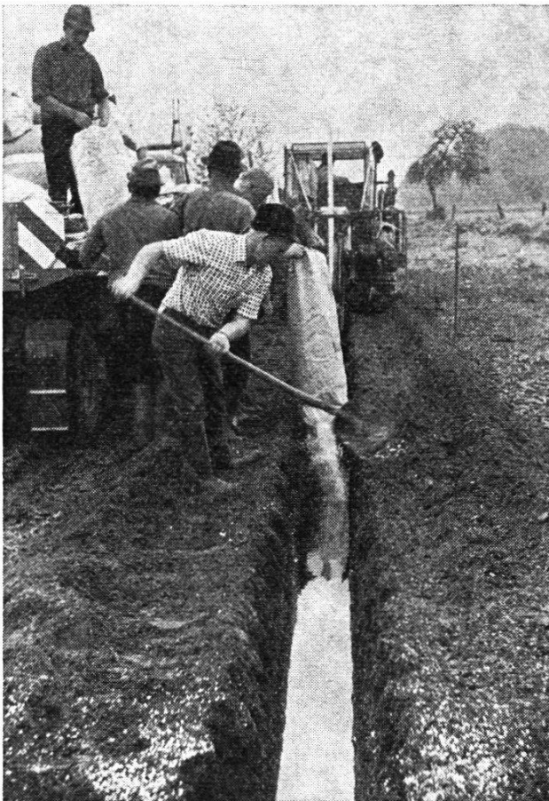
Bild 6: Zur Sicherung eines extrem hohen Wasserabflusses wurden die PVC-Dränrohre eines Abwasser-Rieselfeldes mit einer besonders dicken Styromull-Filterschicht bepackt
