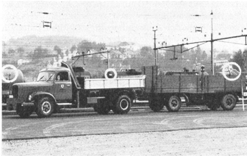
Abb. 7: Saurer DU5 mit Anhänger und installierten Markierungsscheinwerfern.
