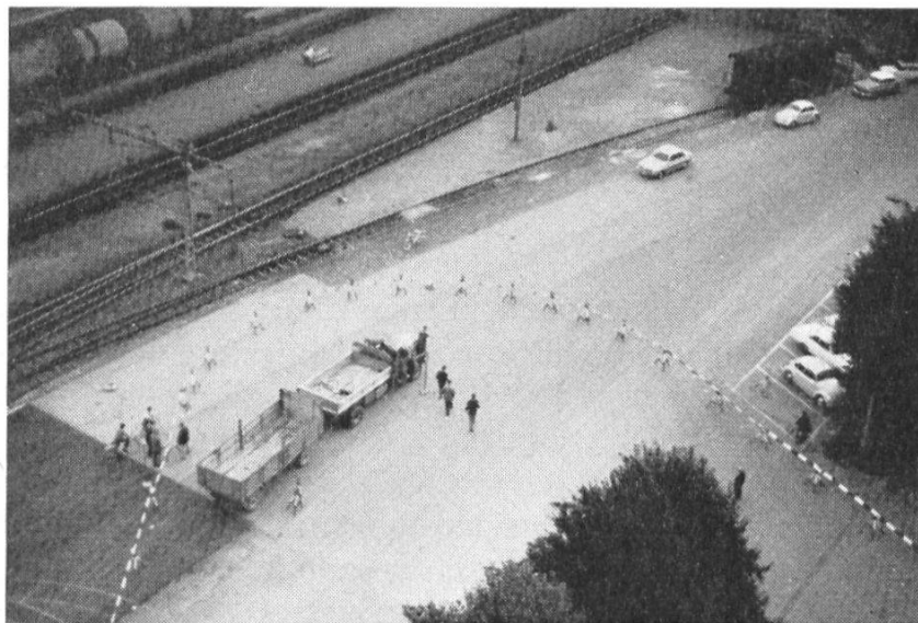
Abb. 8: Abgesteckter und markierter Fahrbahnrand. Mit Hilfe der vorgängig durch Kartontafeln bezeichneten Bogenanfänge und Tangentenpunkte konnte diese Markierung von 4 Mann in wenigen Minuten umgestellt werden.
