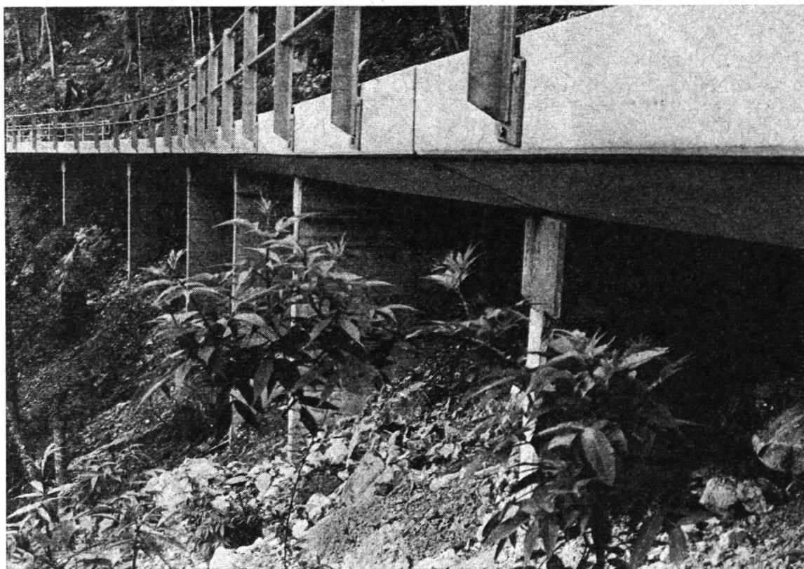
Bild 4: Detailuntersicht auf den vorfabrizierten Lehnenviadukt mit Geländerbefestigung
