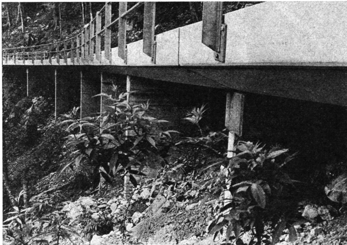
Bild 4: Detailuntersicht auf den vorfabrizierten Lehnenviadukt mit Geländerbefestigung
