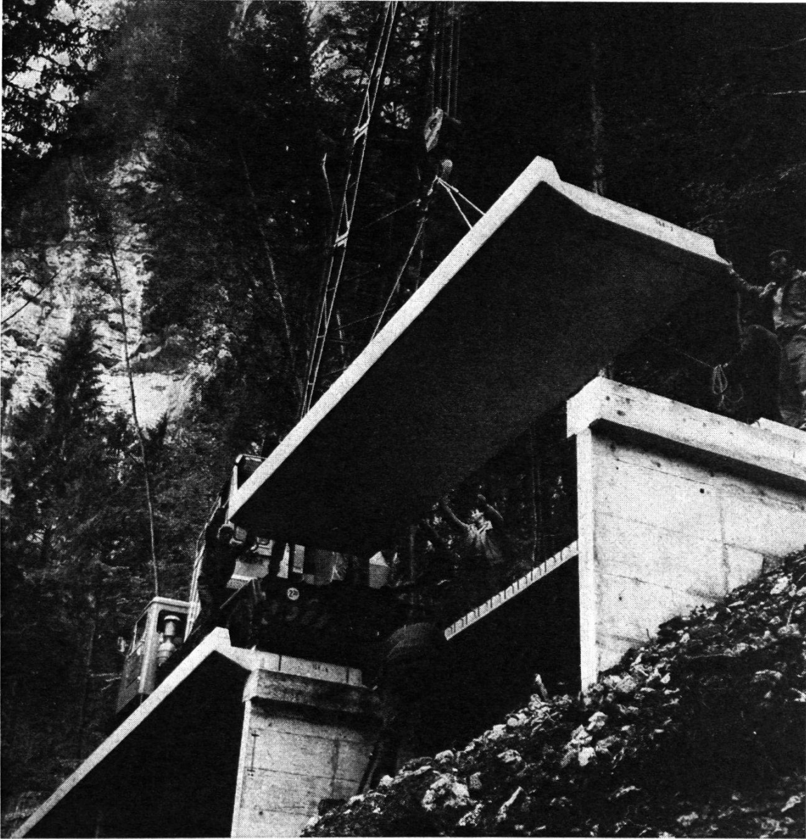
Bild 2: Verlegen der vorgefertigten Plattenelemente mit Pneukran auf vorbereitete Stützwände
