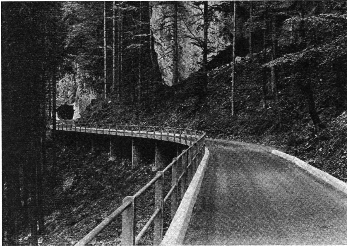
Bild 3: Fertigerstellter Lehnenviadukt als Fortsetzung einer Tunnelpartie; Fahrbahnbreite 3,60 m, Längsgefälle 10,5%
