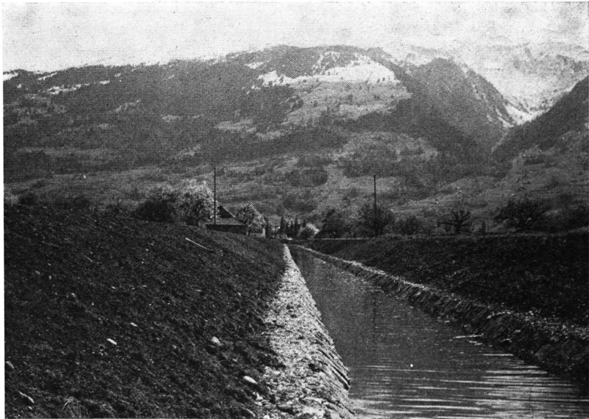
6. Neuer, naturverbunden ausgebauter Vilterser-Wangser Kanal.
