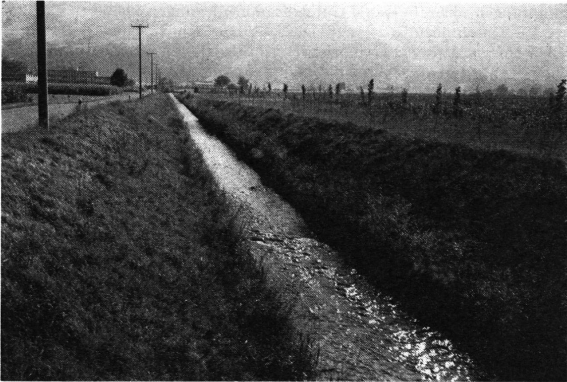
3. Korrigierter Vilterser-Wangser Kanal. Natursteinpflasterung als Uferschutz, Kiessohle und Rasenböschung. Links die Zufahrtstraße nach Wangs, rechts neu angeplanter Windschutzstreifen. Melioration der Saarebene.
