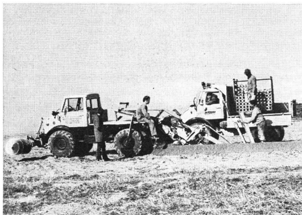
Abb. 7 «Hoes» zu Unimog. Einsatz in Hügelland (sandiger Lehm), Grabentiefe 1,1 m; Rohrmaterial: Ton \varnothing 80 mm.
