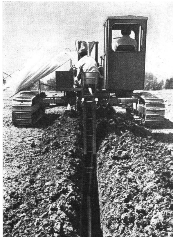
Abb. 3 «GFP 3», Verlegung von KD-Flex (Werkphoto).
