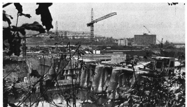
Bild 6: Neues Kraftwerk Bremgarten-Zufikon im März 1975 Foto: Aargauisches Elektrizitätswerk
