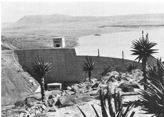
Abb.1 Lubisi-Staudamm in der Transkei (Heimatland der Xhosa, das am 26. Oktober 1976 unabhängig wurde). Bildet Bestandteil des Quamata-Bewässerungsprojektes, das ausschliesslich für 1200 Bantu-Familien bestimmt ist. Die Farmgrösse beträgt etwa 2 Hektaren.
