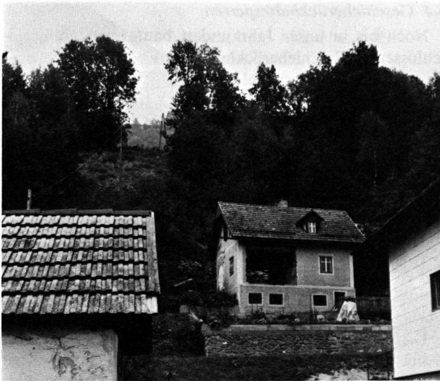
Abb. 10 Eine «kleinere» Hangexplosion löste sich bei Ferndorf oberhalb des mittleren Hauses und durchstieß ein Zimmer (die Mauer wurde nicht nachträglich noch sauber herausgetrennt; dieses Bild präsentierte sich unmittelbar nach der Hangexplosion). Der übrige Teil des Hauses blieb unbeschädigt.
