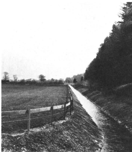
Abb. 4 Der korrigierte Saschielbach, gleichzeitig Trennungslinie zwischen Wald und Kulturland. Im Hintergrund Windschutzanlage
