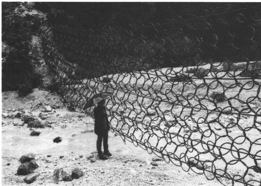
Abb. 11 Netzsperrre im Werkstattgraben. Sie dient dem Rückhalt des Triebholzes, damit die selbsttätige Entleerung im untenliegenden Geschiebeablageungsplatz nicht durch Verkläunungen behindert wird
