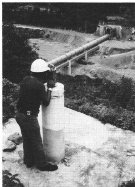
Abb. 7 Arbeit am Vermessungspfeiler
