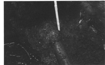
Abb. 10 Aufgegrabenes Drainflexrohr mit Holzwollefilter im Lüscherzmoos.
