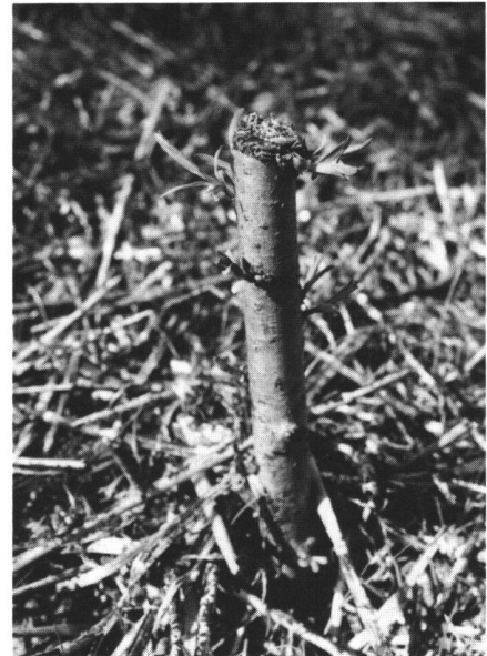
Abb. 3 Steckholz: Weidenäste werden auf die benötigte Grösse abgelängt und in die Böschung geschlagen. Schlafende Knospen treiben aus, bilden Triebe und Wurzeln und regenerieren das Steckholz zu einer vollwertigen Pflanze.
