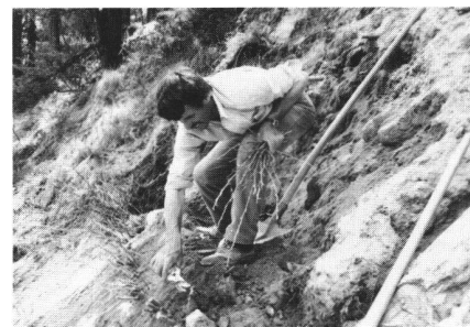
Abb. 7 Heckenlage im Hangrost: Mit dem Aufbau der Böschung werden abwechselungsweise Holz und Busch- bzw. Heckenlagen mit Erdmaterial hinterfüllt. Vor dem weiteren Aufbau sind die Pflanzen auf die optimale Länge zurückzuschneiden.
