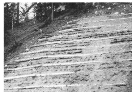
Abb. 8 Der Hangrost ist erstellt. Die Oberfläche wird zusätzlich mit Strohdecksaat geschützt. Die Pflanzen werden im Laufe der Zeit die Stützfunktion übernehmen.
