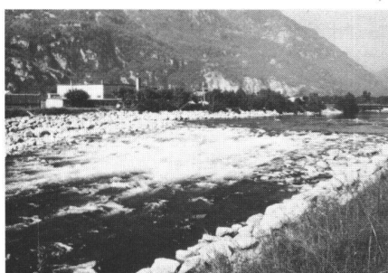
Abb. 3: Blockschwelle im Tessin bei Lodrino, mit einer Absturzhöhe von ca. 5 m. Die Anordnung der Schwelle ergab sich aus dem hydraulischen Modellversuch. Insbesondere wurde eine raue Oberfläche empfohlen, was die Kolkbildung vermindert und den Aufstieg von Fischen und Kleintieren ermöglicht.
