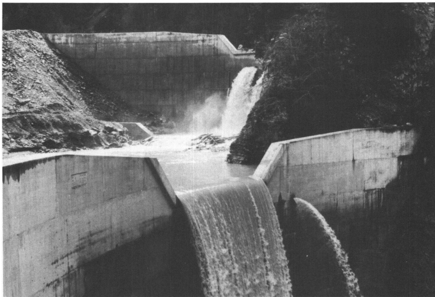
Abb. 1: Wildbachsperren am Schraubach (GR), mit Absturzhöhen von ca. 12m. Die VAW untersuchte den Kolkvorgang und die Kolkssicherung.
