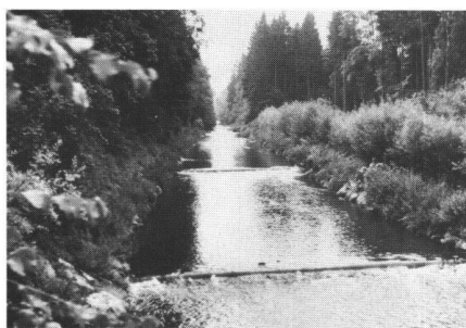
Abb. 2: Querschwellen (Traversen) in der Murg (TG). Anwendung eines an der VAW systematisch untersuchten Verbauungssystems.
