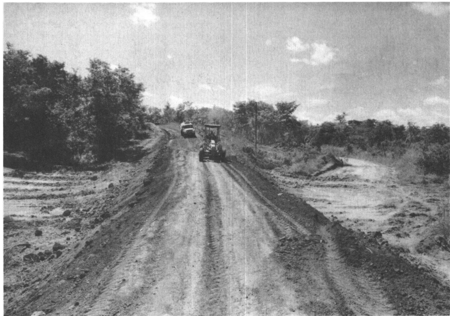
Abb. 4: Oft werden Wasserstellen künstlich geschaffen; z.B. während grösserer Erdarbeiten entstehen Senken oder Verdichtungen, in denen Wasser stehen bleibt. (Foto: IfK, Strassenbau in Tansania).
