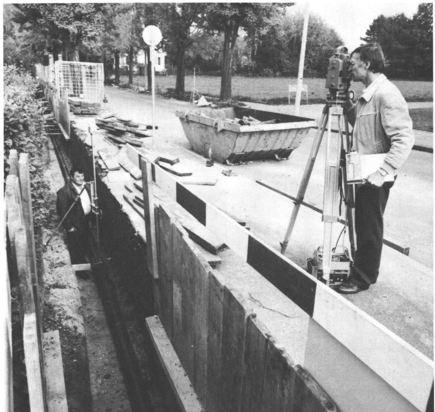
Abb. 3: Einmessung der fertig verlegten Leitung für die Nachführung des Leitungskatasters. (Foto: Vermessungsamt Kanton Basel-Stadt).
