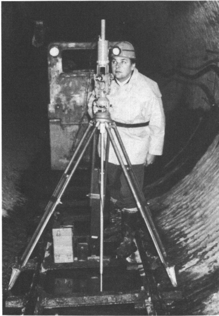
Abb. 2: Achs-Kontrolle mit dem Kreiselttheodolit in einem Abwasser-Stollen. (Foto: W. Schneider AG).
