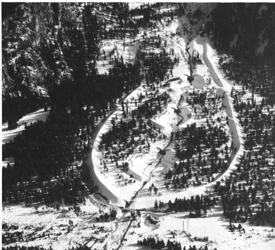
Abb. 4: Tränenbach in der Gemeinde St. Anton im Montafon: Die drei Geschiebeablagerungsplätze wurden durch grössere Umfassungsdämme zu einem einzigen vereint.
