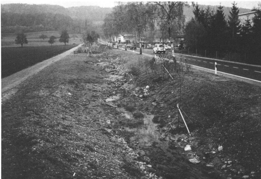
Abb. 3, 4: Chämmeterbach in Dübendorf vor und nach der Revitalisierung.
