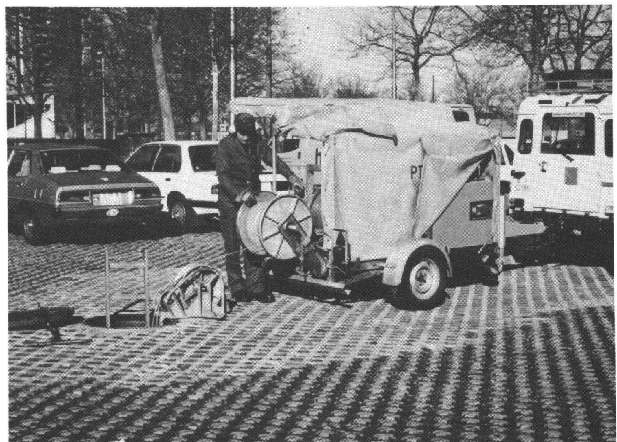
Abb. 8: Kabeleinzug: Vorbereitungsarbeiten für den Einzug eines Glasfaserkabels. Tirage de câble: préparation des travaux pour le tirage d'un câble à fibres optiques.
