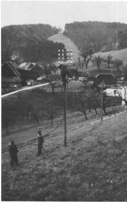
Abb. 6: Freileitung: Ersatz einer konventionellen Freileitung durch ein Luftkabel.
