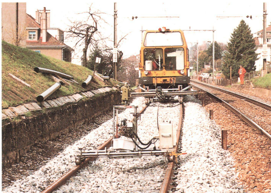
Abb. 10: Automatische Richt-, Nivellier- und Stopmaschine ausgerüstet mit dem neuen Lasersystem. Mit dem Distanzmesser im Vordergrund wird die Horizontaldistanz und die Höhendifferenz zum Gleisversicherungspunkt gemessen. Der Bordcomputer ermittelt durch den Vergleich der Ist-Werte mit den Soll-Werten die effektive Schiebung bzw. Hebung in diesem Punkt.
