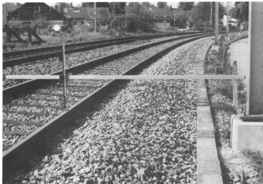
Abb. 9: Messlehre für die Lage- und Höhenkontrolle der Gleise bei den Bolzen oder den 5-m-Punkten durch das Bahndienstpersonal.
