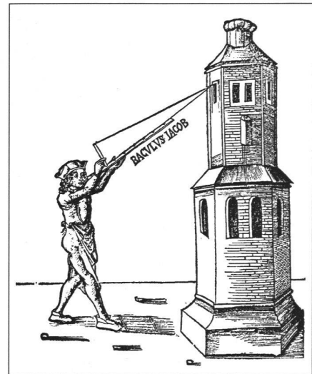
Abb. 1: Baculus Jacob (Jakobsstab) nach einer Darstellung in G. Reisch, Margarita philosophica, 1496. Der Zeichner dieses Holzschnittes hat die Handhabung des Gerätes überhaupt nicht verstanden und deshalb vollkommen falsch dargestellt (vgl. Abb. 13).
