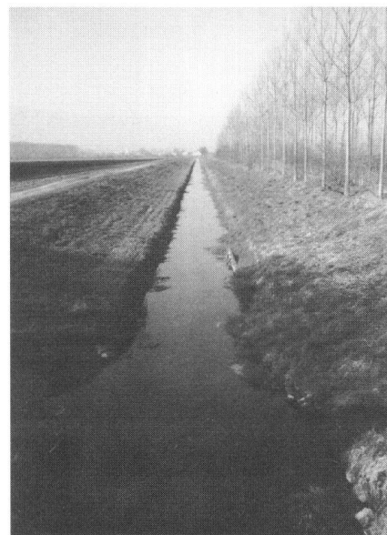
Abb. 4: Der Kanal in der Orbe-Ebene: heute Entwässerungskanal.
