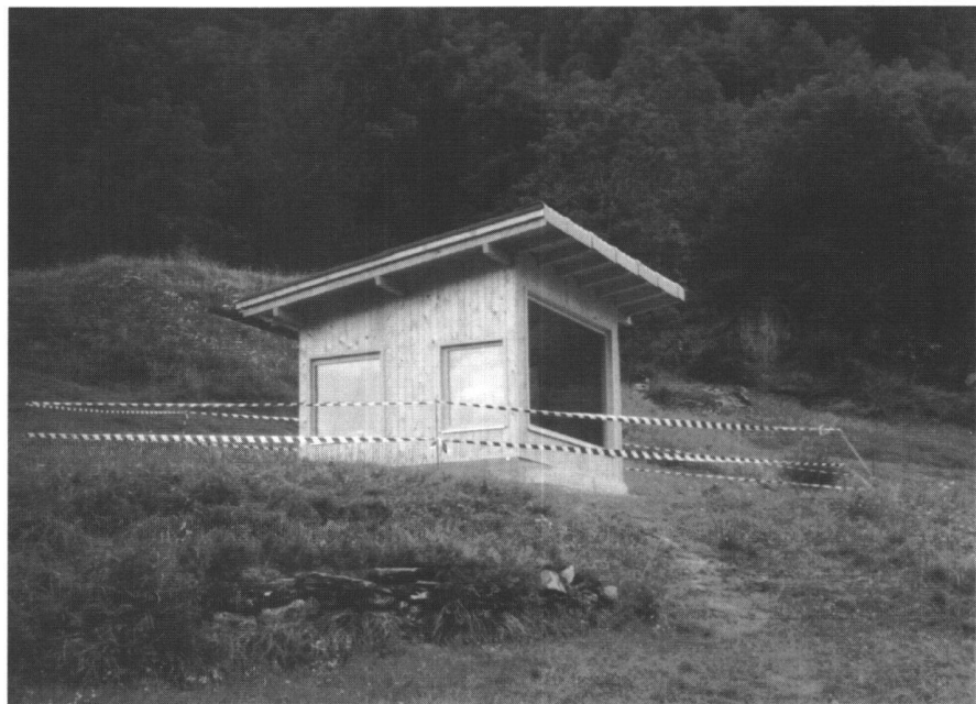
Abb. 4: Messhäuschen mit Fenster aus Floatglas.
