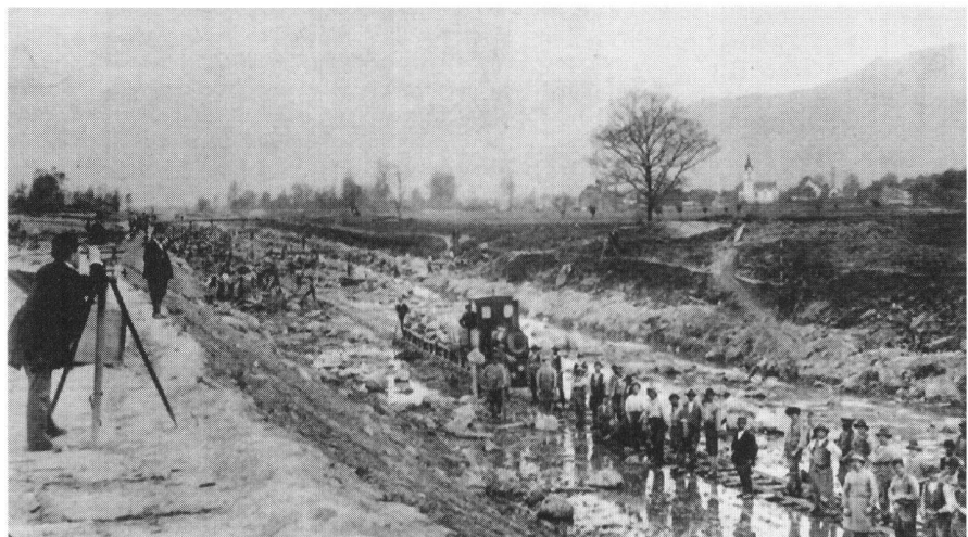
Abb. 1: Bau des Werdenberger Binnenkanals bei Salez 1882/83.
