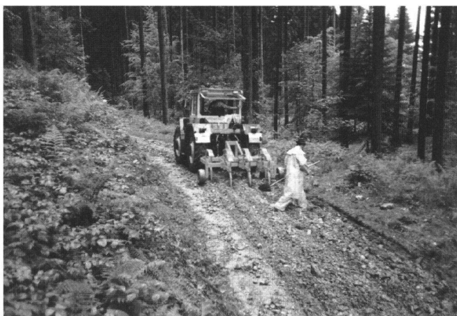
Abb. 1: Vor der Verstärkung wird der alte Strassenkoffer aufgerissen.
