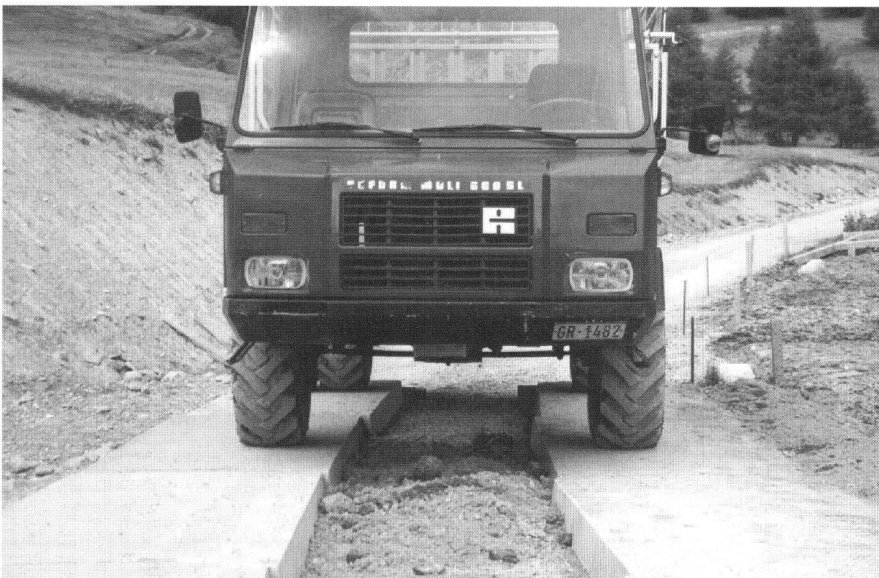
Fertig gestellte Betonspuren vor dem Einfüllen von Mittelstreifen und Bankett. Bandes de roulement en béton avant le remplissage de la bande médiane et des accotements.
