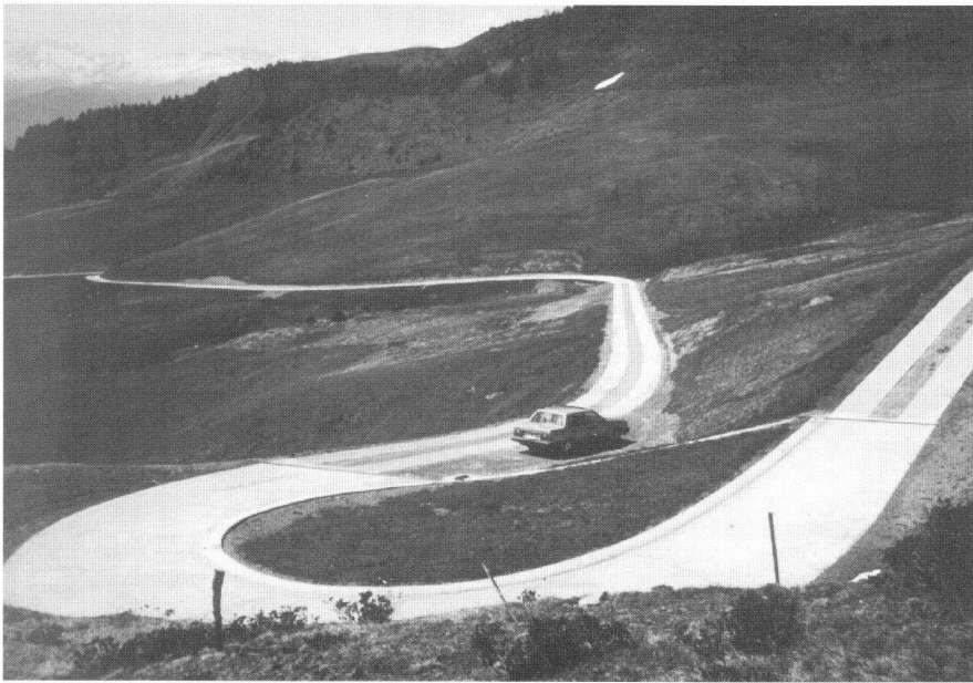
Abb. 1: Spurweg. Fig. 1: Bandes de roulement.
