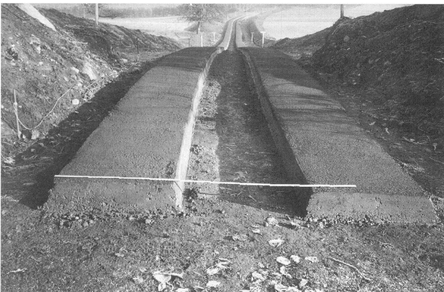
Abb. 3: Ortsbetonspuren maschinell eingebaut. Gesamtmelioration Lieli (LU). Fig. 3: Bandes de roulement en béton coulé sur place posées à la machine. Amélioration intégrale de Lieli (LU).
