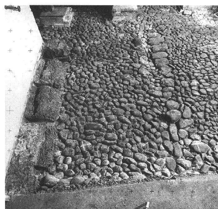
Originalaufnahme Bodenpflasterung Haus Ägerstrasse 7 in Zug.
